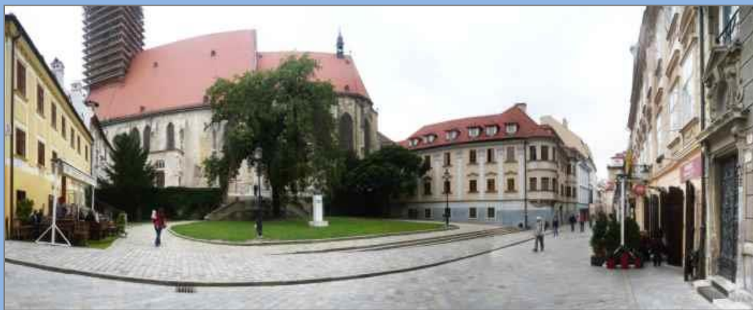
Obr.1: Budova Jazykovedného ústavu ĽŠ SAV v Bratislave
